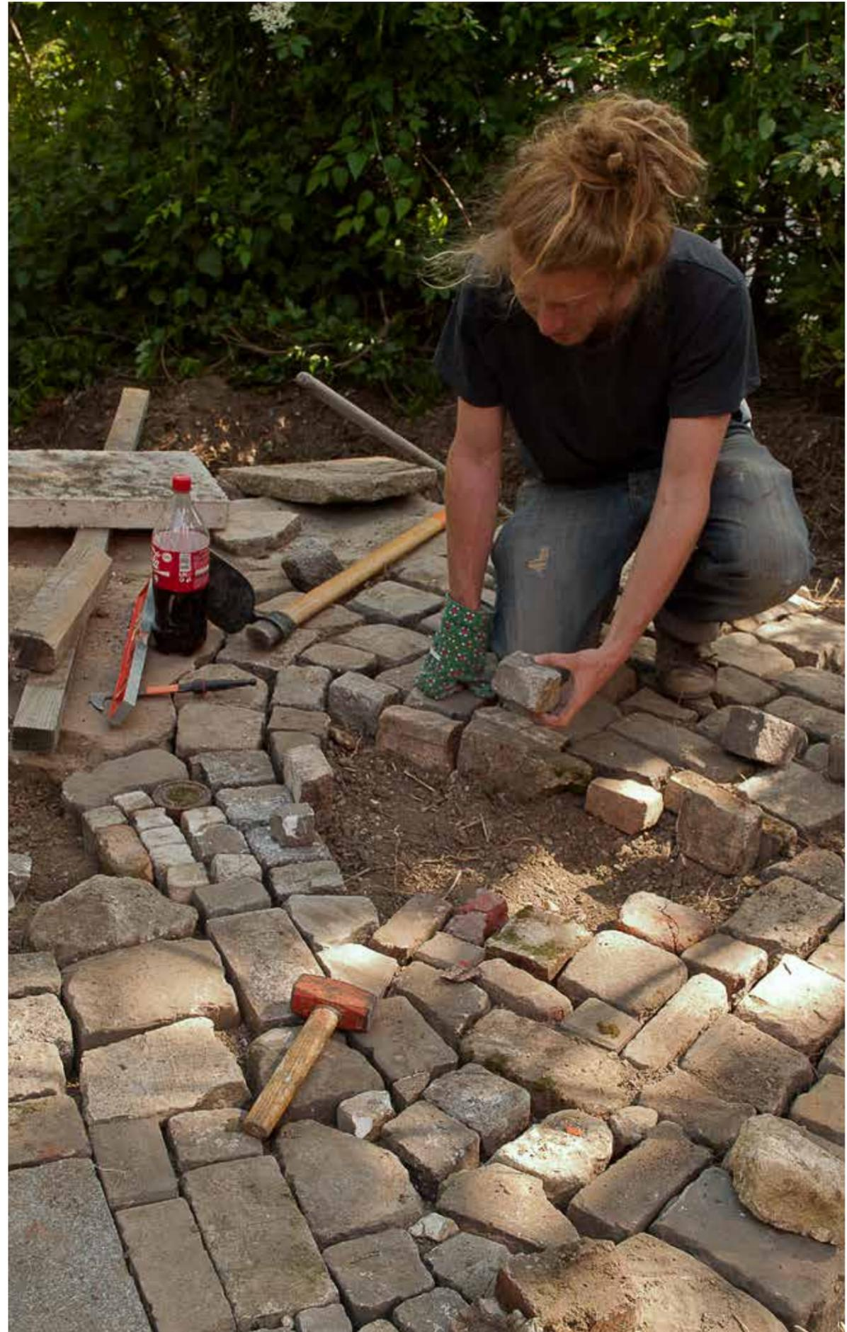
**RECYCLAGE DE PAVÉS ET MORCEAUX DE DALLE EN BÉTON**
