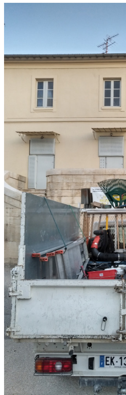
à gauche : ouverture du chantier / en haut :
